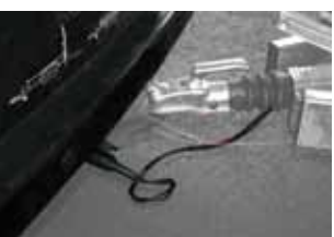
Bild: Stromversorgung anschließen
